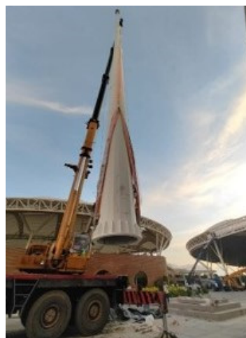
图 11. 巨型旗杆安装现场。
